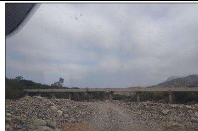
Cruce de canal Ventanillas expuesto
